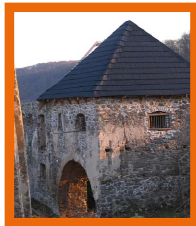
Hrad Čabrad' po rekonštrukcii
